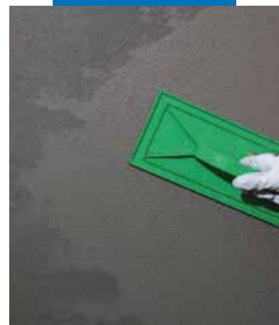
Frattazzatura di Mapegrout 430
