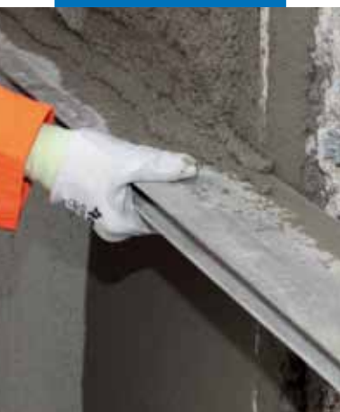
Staggiatura di Mapegrout 430
